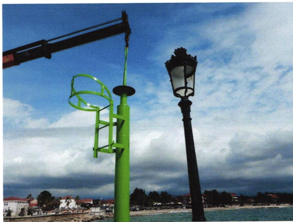
Slika 15. Luka Vir – Sapavac, postavljanje lučkog svjetla
