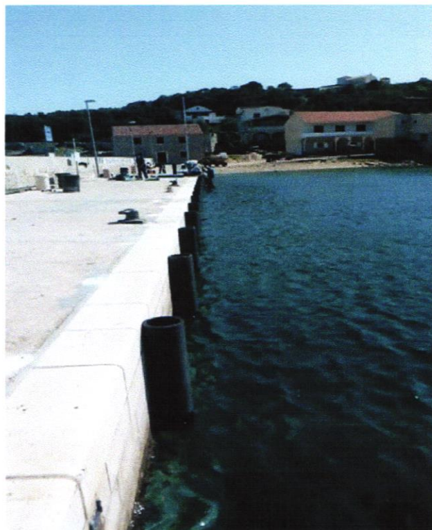
Slika 19. Ugradnja bokobrana u luci Vrgada
